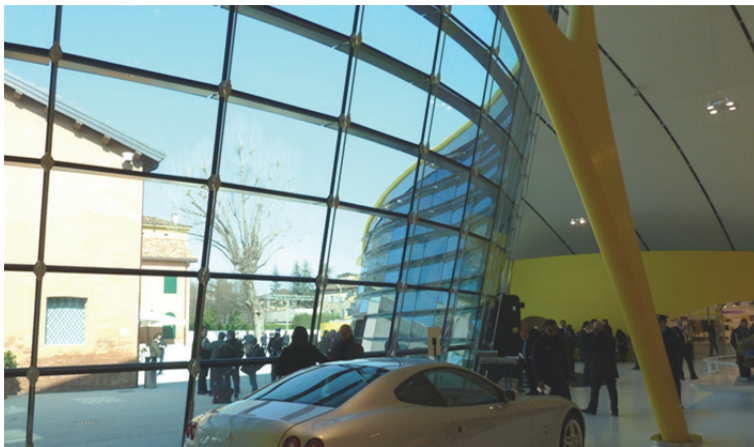
Bild 3-3 Glasfassade, Sicht von innen
