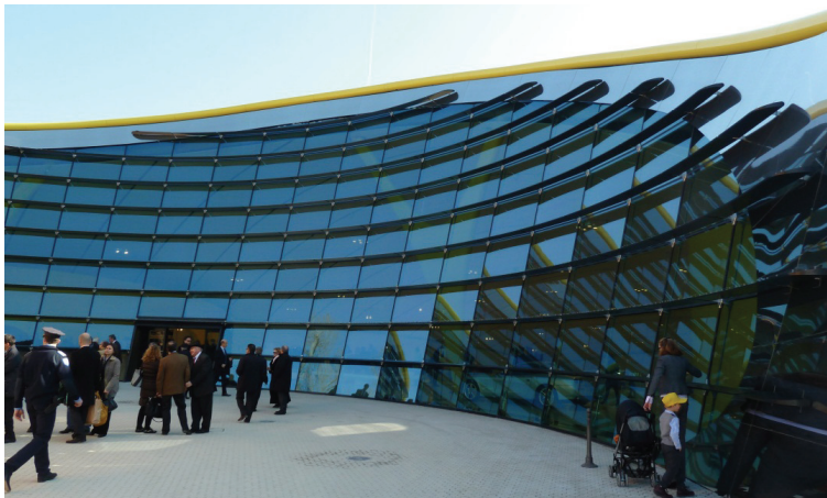
Bild 3-1 Glasfassade, Sicht von außen
